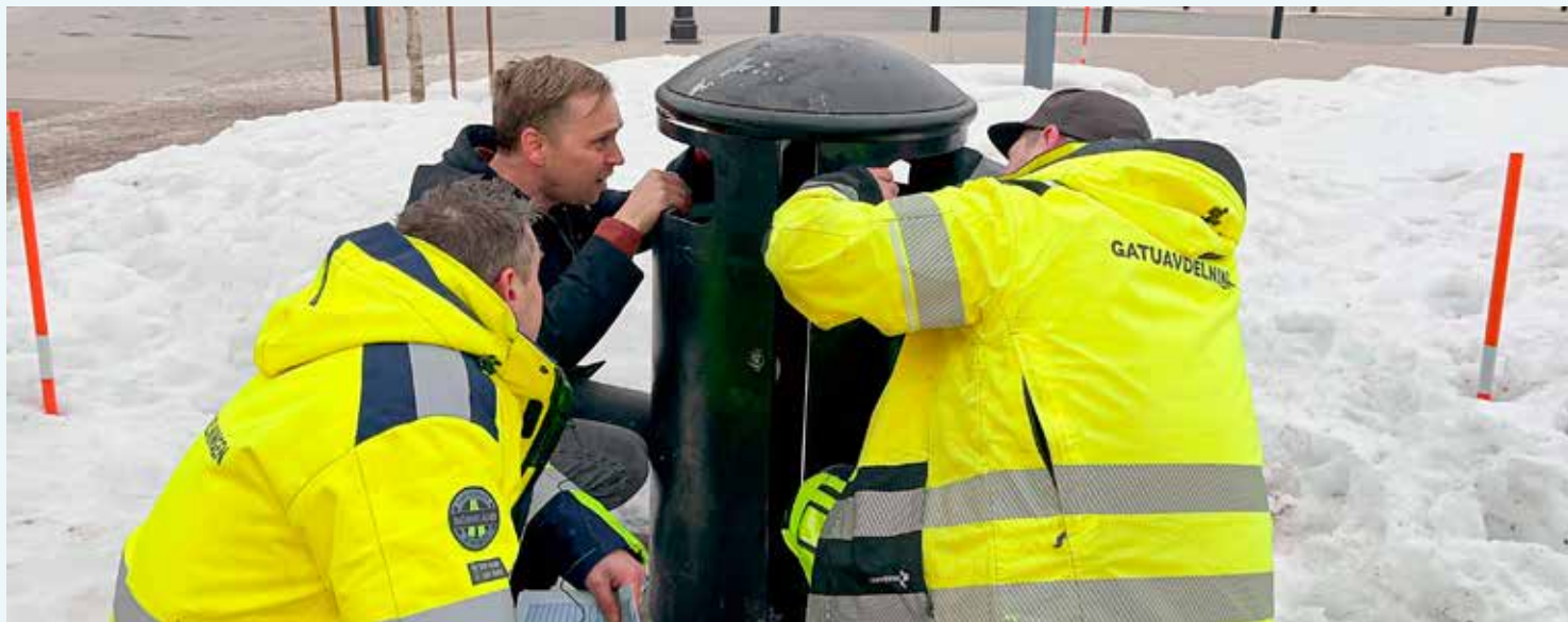
▲ Montering av en sensor i en soptunna. Foto: Sundsvalls kommun
